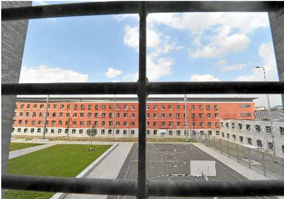
Das Gefängnis in Offenburg (Bild) gilt als Beispiel für den geplanten Neubau in Rottweil. Foto: Seeger Foto: Schwarzwälder-Bote
