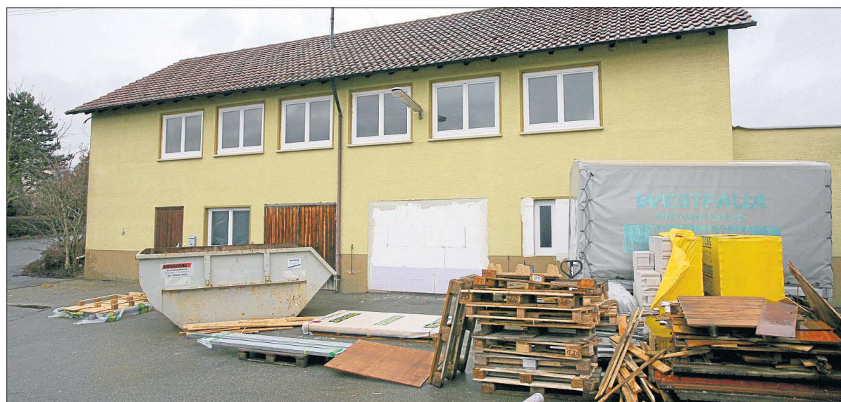
Da wird geschafft: Größtenteils in Eigenleistung saniert die Geislinger Narrenzunft den alten Bauhof in der Schaffbrunnensstraße. Im Mai 2012 wollen die Narren in ihr neues Zuhause einziehen. Die neuen Fenster sind bereits eingebaut. Foto: Mohr
